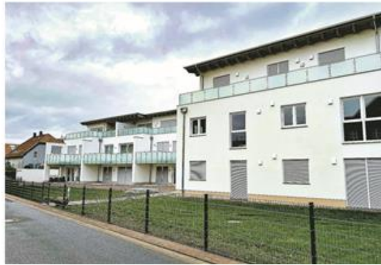
Die 16 Wohnungen in den beiden Häusern an der Oberntorstraße sind bezugsfertig.
